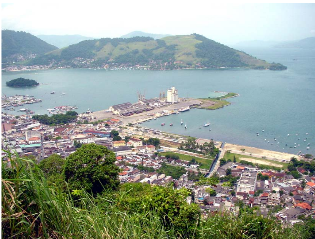
FIGURA 10 - Vista panorâmica do Centro de Angra dos Reis, com o Porto. À direita, junto à orla, as áreas vazias e sub utilizadas do retro porto (Acervo da Prefeitura Municipal de Angra dos Reis).
