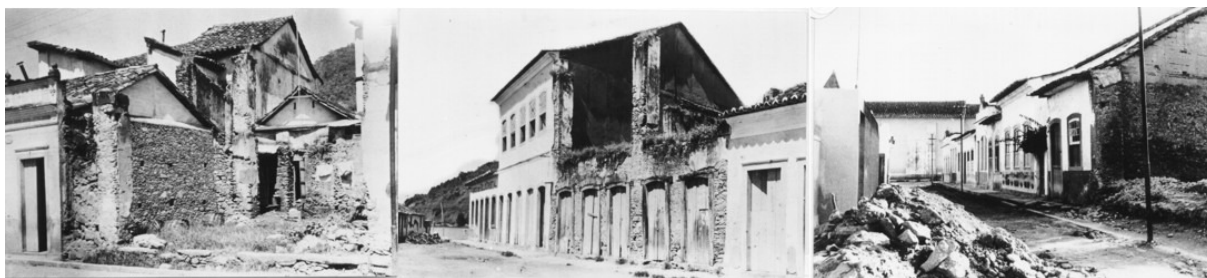
FIGURA 9 - Centro de Angra na década de 1940 - demolições. Extraído da acervo do Instituto do Patrimônio Histórico e Artístico Nacional.
