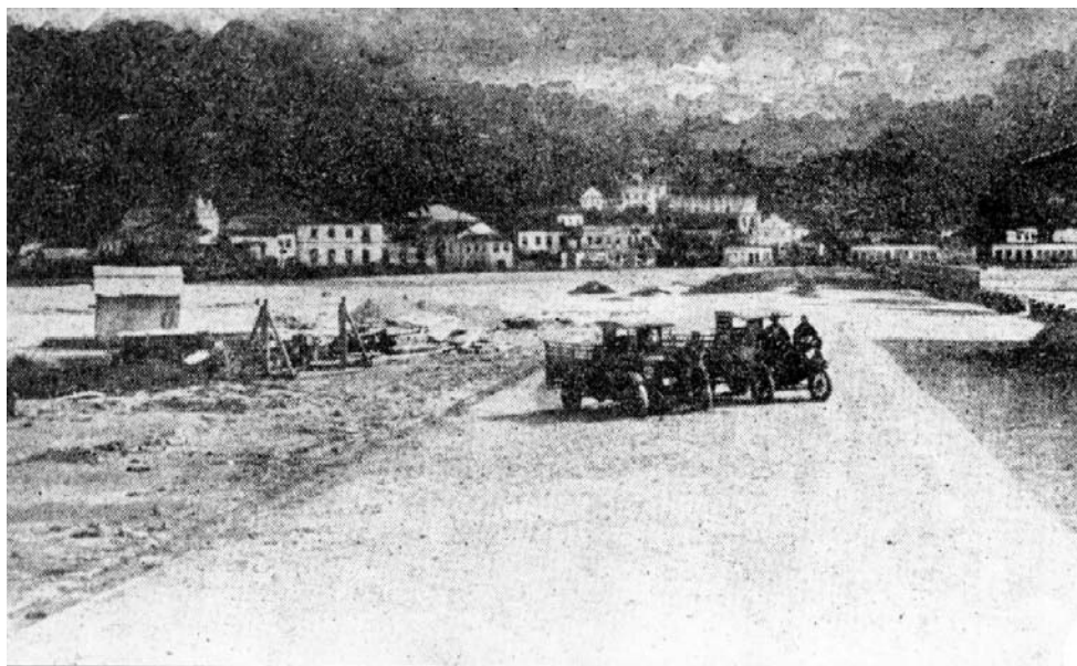
FIGURA 8 - Detalhe do Porto de Angra dos Reis em fase de construção. Foto datada de 1928, publicada na Revista do Ateneu Angrense de Artes e Letras, 1979.
